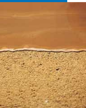
Application de la barbotine d'accrochage pour chape adhérente Mapecem
