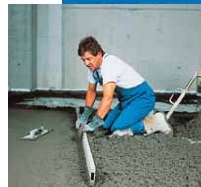
Étalement et damage du mélange Mapecem
