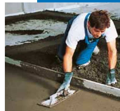
Finition par talochage du mélange Mapecem
